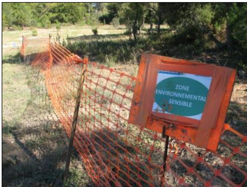
Exemple de matérialisation physique de limites de chantier
